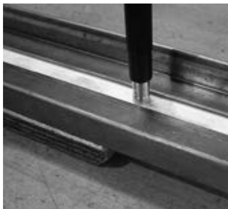
Einschlagen des Belüftungsrohrs Enfoncement du tube de ventilation Driving the ventilation tube home
