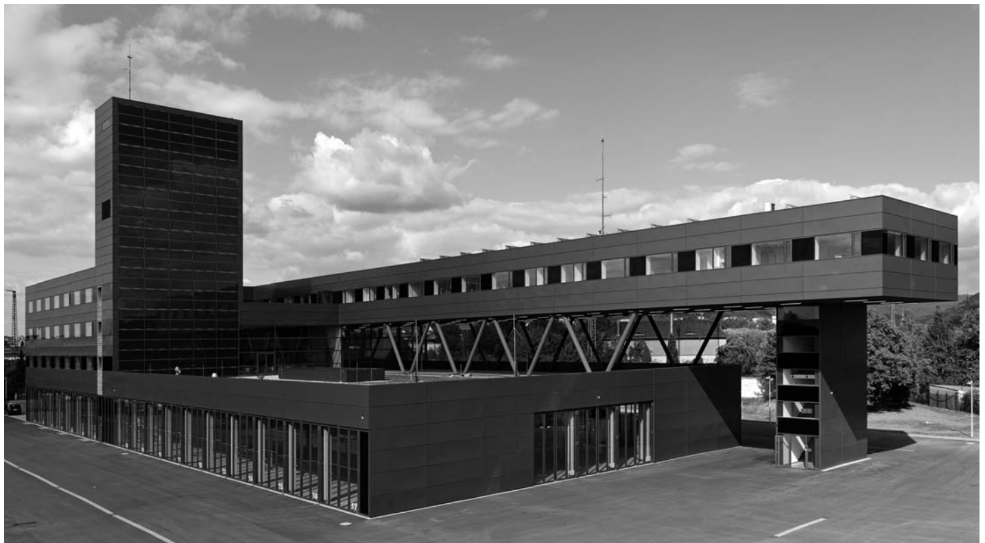
Feuerwehrwache Heidelberg, Heidelberg/D
