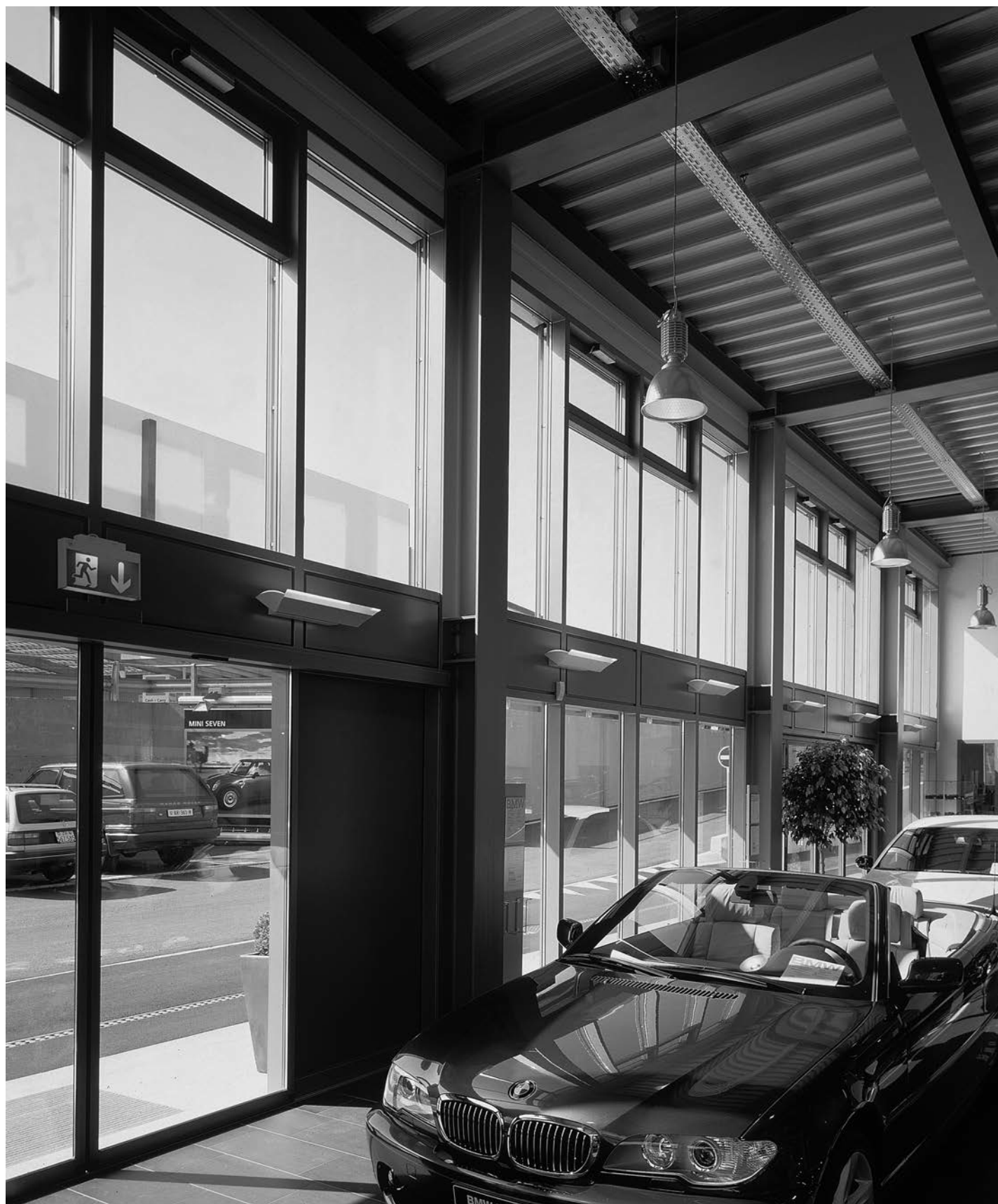
Garage, Jona/CH (Architekt: Ziegler und Partner, Architekten)
